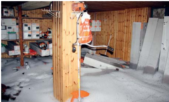
Das Löschwasser musste als Sondermüll entsorgt werden. Selbst Räume, die auf den ersten Blick nutzbar erschienen, mussten aufwendig saniert werden.
